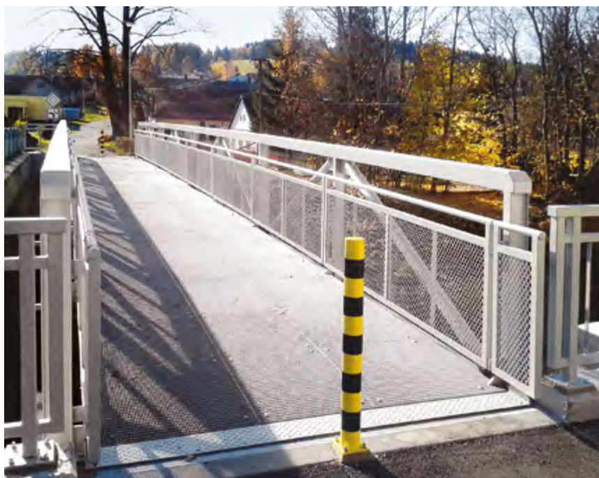
lávka Trhová Kamenice
