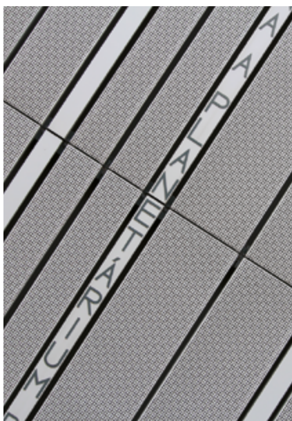
oplaštění z děrovaného plechu
